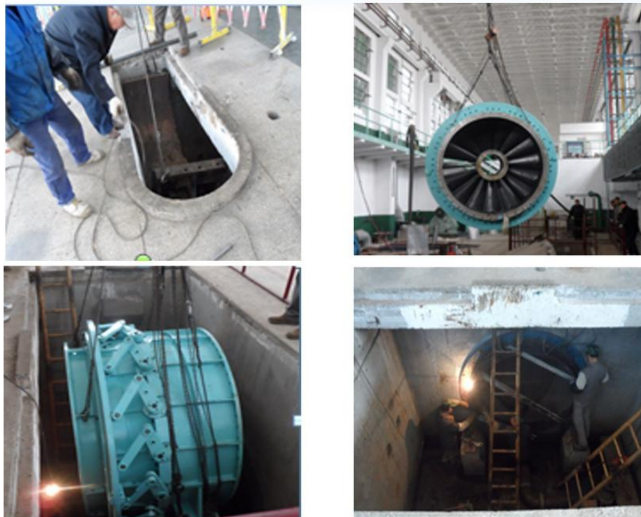
图 2 运西水电站现场水轮机安装照片
