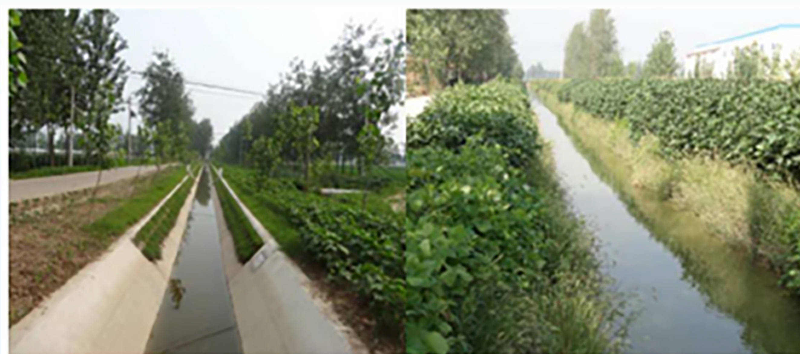
已建混凝土生态防渗渠道改造图
